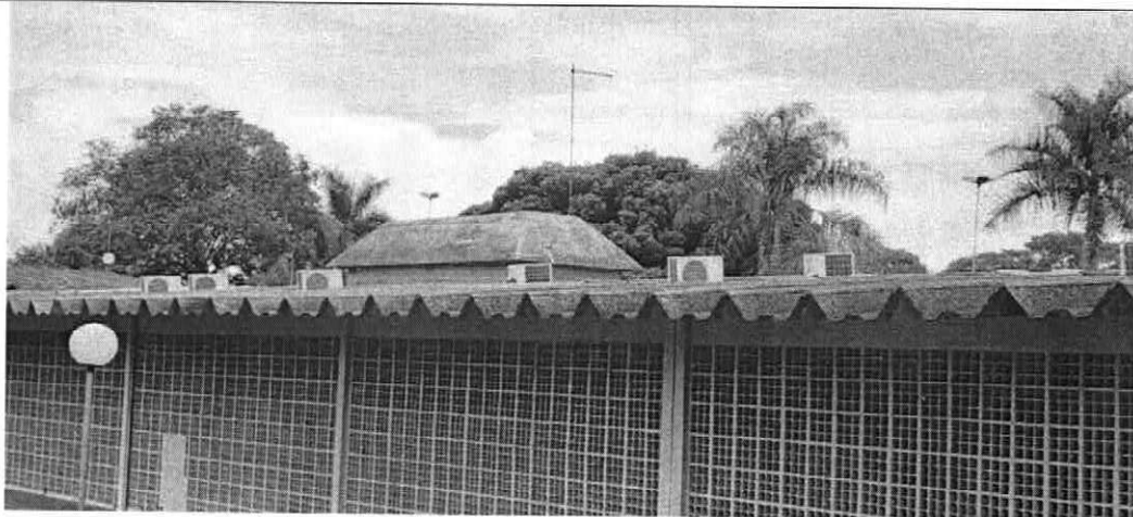
Uma das caixas de água da unidade sobre o telhado
