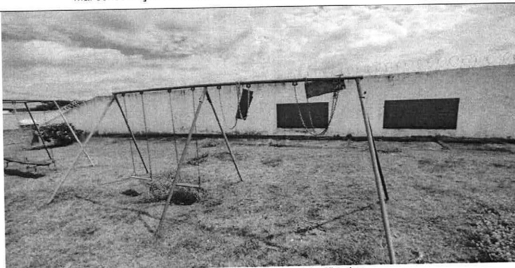
Brinquedos do playground danificados
